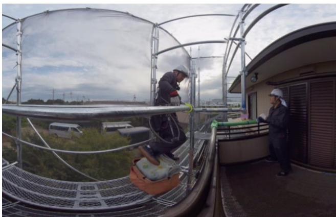
日常の作業風景の中から危険箇所を探し出す
