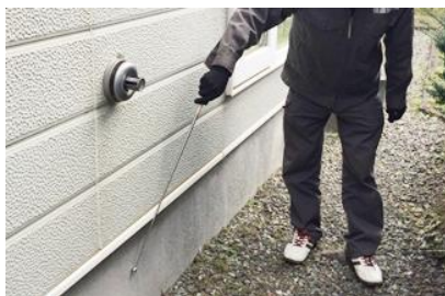
音で内部の状況をチェックする様子
